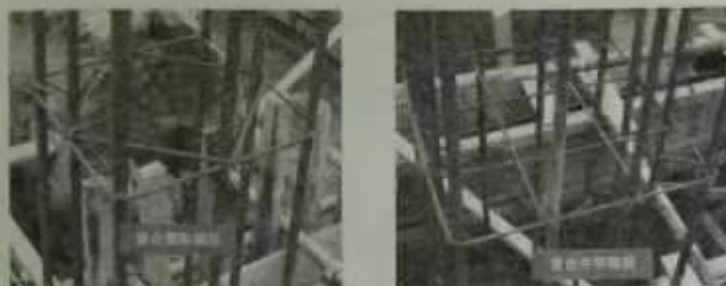
图 3-5 常用复合箍筋配筋形式
